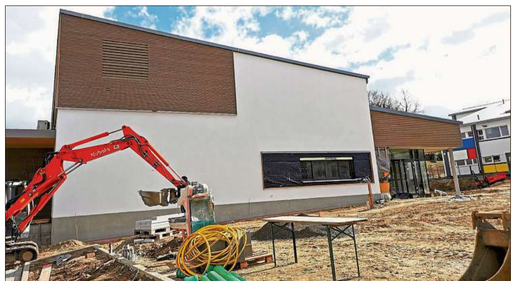
Als Nächstes stehen für die neue Münchgrundhalle in Altdorf die Elektro- und Sanitätsinstallationen an. Foto: Decoux
