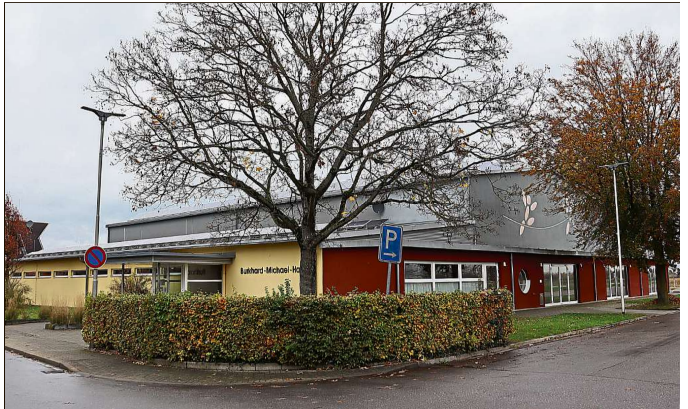
Für die Nonnenweierer ist klar: Die neue Grundschule sollte in ihrem Ortsteil gebaut werden. Einen großen Vorteil sehen die Räte darin, dass keine zusätzliche Halle nötig ist, da die Burkhard-Michael-Halle genutzt werden kann. Foto: Hamsch
