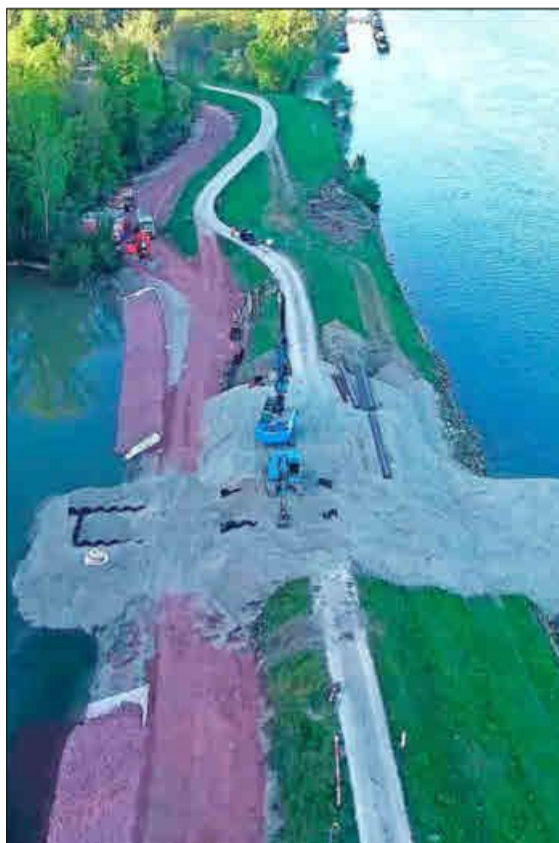
Das erste von zwei Einlassbauwerken am Rhein (rechts) soll Ende des Jahres in Betrieb gehen.
