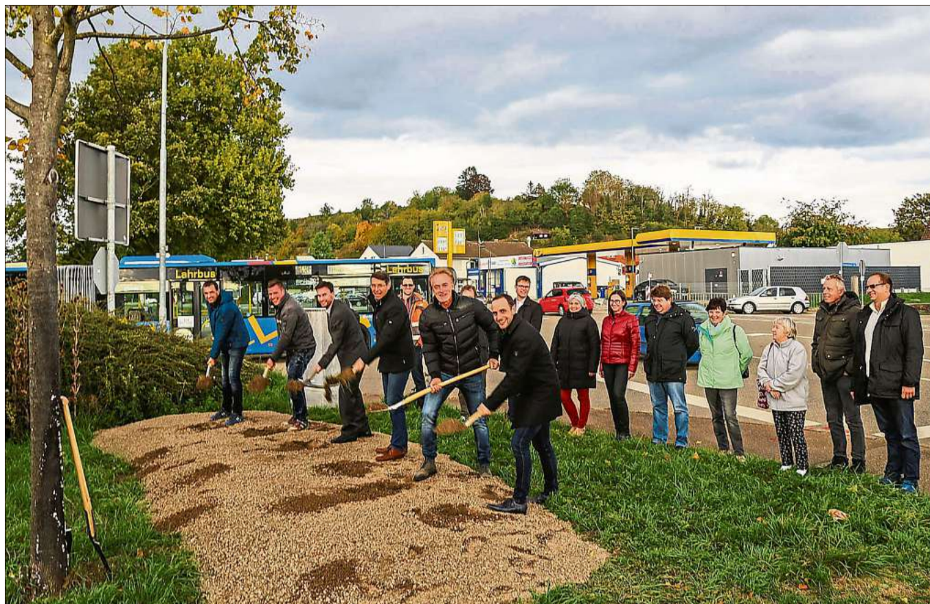
Für den Baustart der Ampelanlage griffen sie in Altdorf zum Spaten (von links): Ortsvorsteher Andreas Kremer, Jan Schneekloth von der bauausführenden Firma Trenkle, Ingo Hugle, Leiter des Baureferats Regierungspräsidium, Bürgermeister Bruno Metz, Peter Arnold vom Straßenbauamt und Johannes Sackmann vom Ingenieurbüro Zink. Foto: Decoux-Kone
