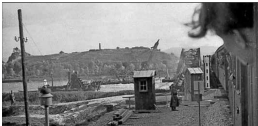
Fahrgäste blicken auf die zerstörte Bahnbrücke bei Breisach. Sie selbst fahren über eine Behelfsbrücke, die später ebenfalls gesprengt wurde.
