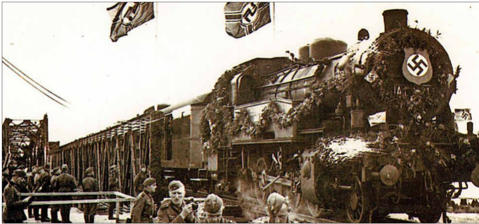
Nach der Sprengung der Eisenbahnbrücke bei Breisach im Zweiten Weltkrieg wurde eine Behelfsbrücke gebaut und am 25. Juli 1940 eingeweiht. Über diese Brücke wurden später 5600 badische Juden ins französische Gurs deportiert. FOTOS: STADTARCHIV BREISACH (2)/HAINMÜLLER
