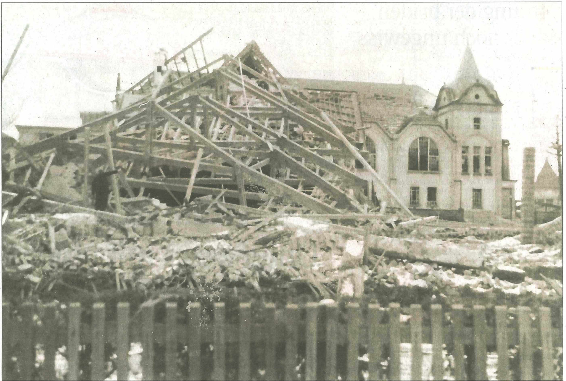
Der schwerste Luftangriff auf Offenburg ereignete sich am 27. November 1944. Dabei fielen mehr als 16 000 Bomben auf die Stadt, es gab 76 Tote. Zerstört wurden etliche Gebäude, darunter die Parklichtspiele, wie das Foto dokumentiert. Im Hintergrund ist die alte Stadthalle zu sehen. Fotos: Stadtarchiv
